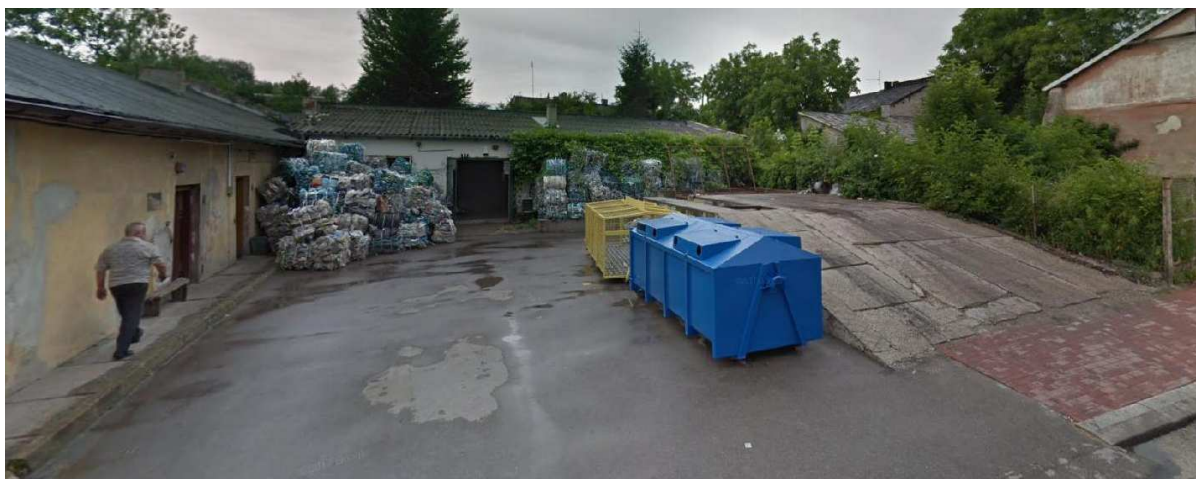
Widok od strony wschodniej – budynki+rampa
