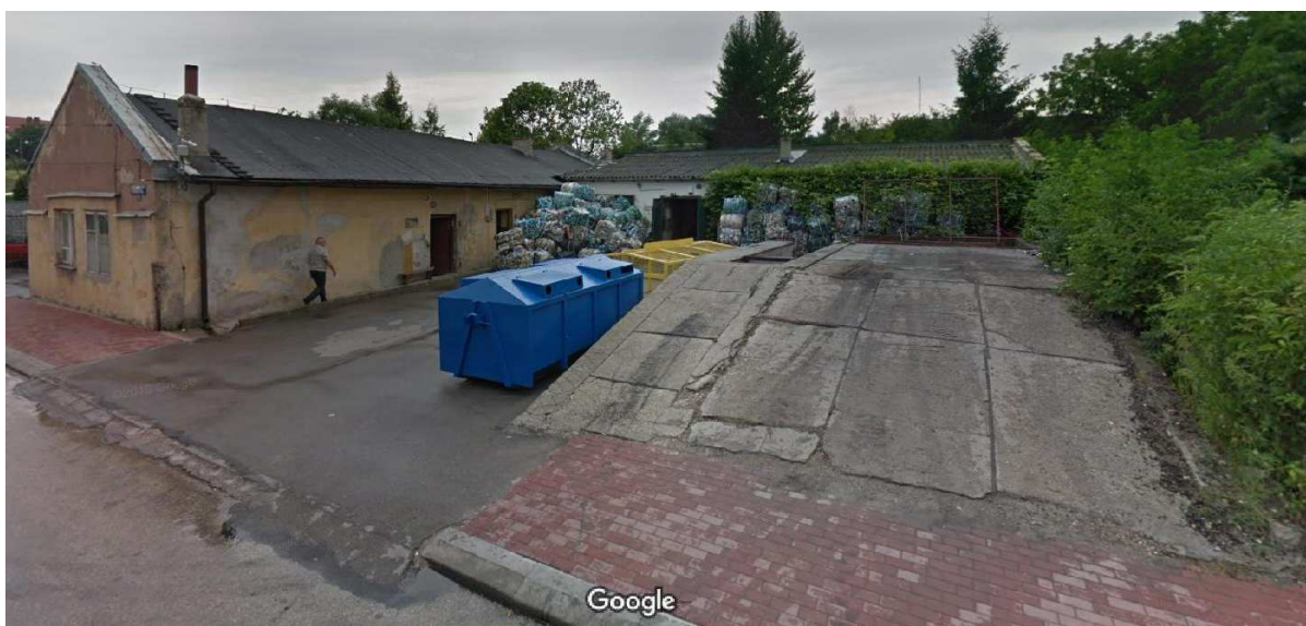
Widok od strony północno-wschodniej – budynki + rampa
